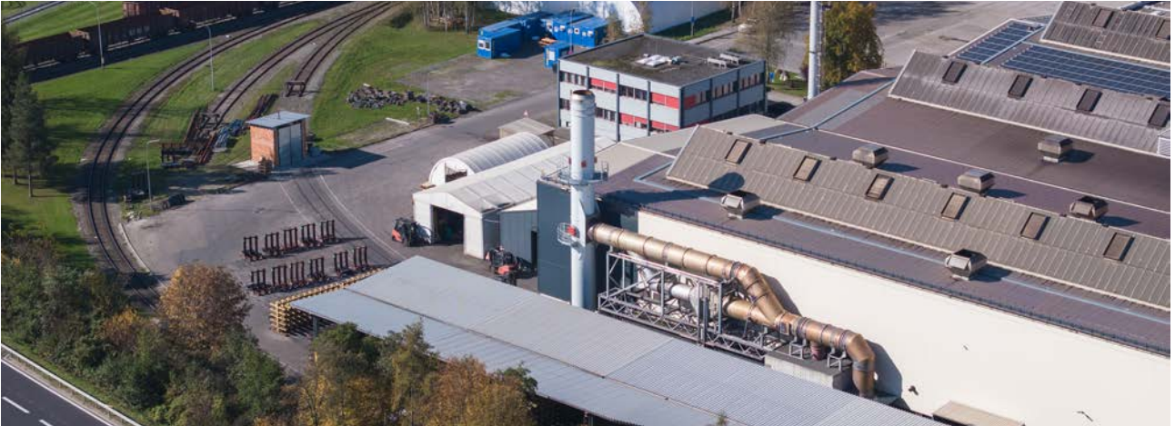
Abb.: DHO-Abgaskamin mit Wärmeauskopplung
