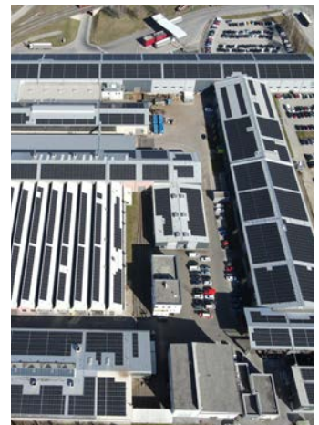
Abb.: PV-Anlage im Bereich der Muffenfertigung
