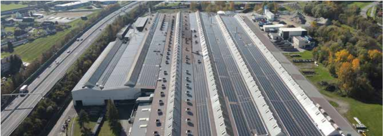
Fig.: PV system
