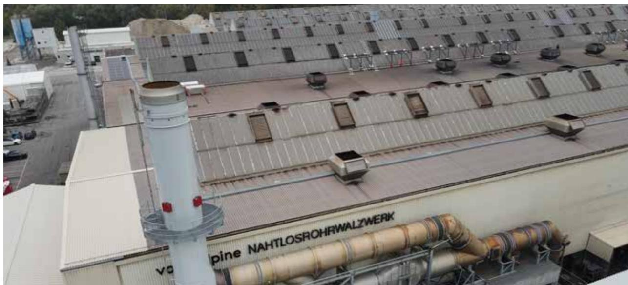
Abb.: DHO-Abgaskamin mit Wärmeauskopplung
