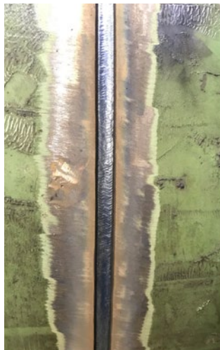
Capa de relleno
